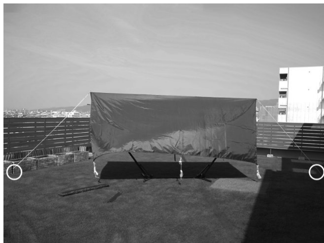
16, 取り付けしたグロメット部分のロープをフレームの外側の延長線上にペグダウンします。
